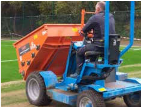
Sablage et épandage du lestage
