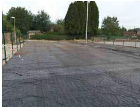
Coffrage et ferrailage
