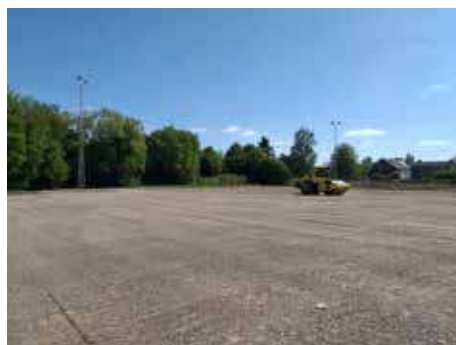
Compactage du fond de coffre
