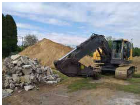
Démontage et démolition
