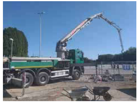
Bétonnage et polissage
