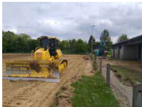
Retroussement de la terre végétale
