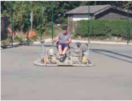
Bétonnage et polissage
