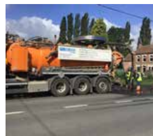
Nettoyage d'une canalisation d'égouttage par une entreprise privée mandatée par la Commune
