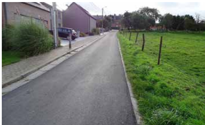
Rue des Saules à Tongrinne : réfection d'une portion de route
