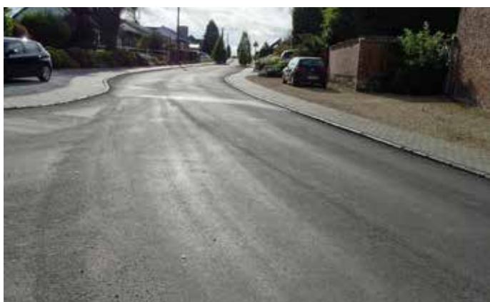
Rue de Wavre à Sombreffe : enduisage d'une portion de route
