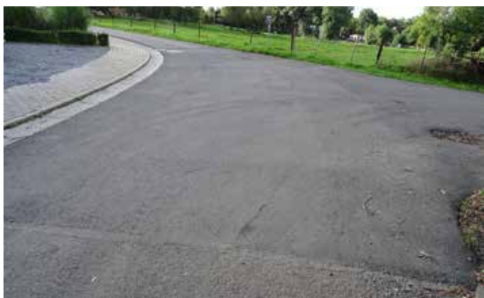
Rue des Combattants à Tongrinne : enduisage d'une portion de route
