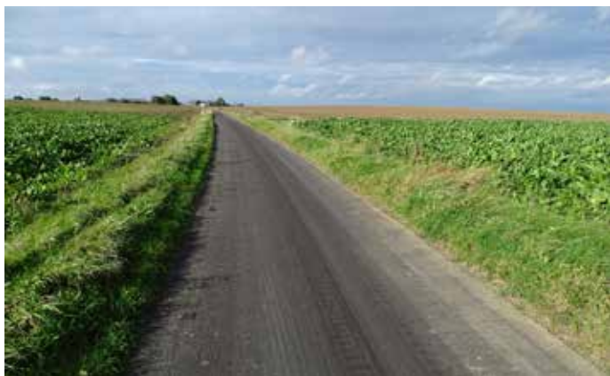
Chemin de l'Ornoi à Tongrinne/Sombreffe : enduisage de toute la route
