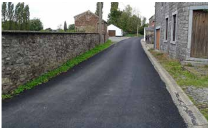
Rue Piconnette à Boignée : enduisage de toute la route
