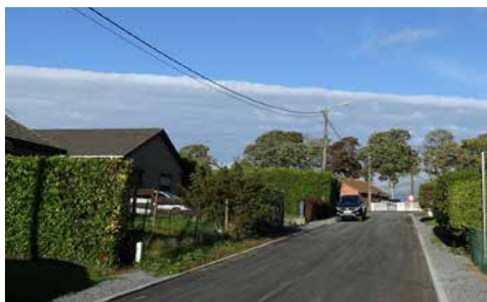
Rue Agnelée à Sombreffe : réfection de la route
