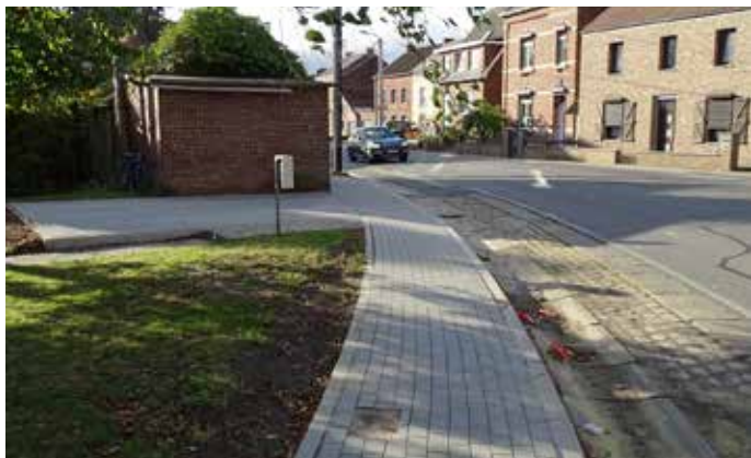
Nouveaux trottoirs également à la rue Pont-Piraux
