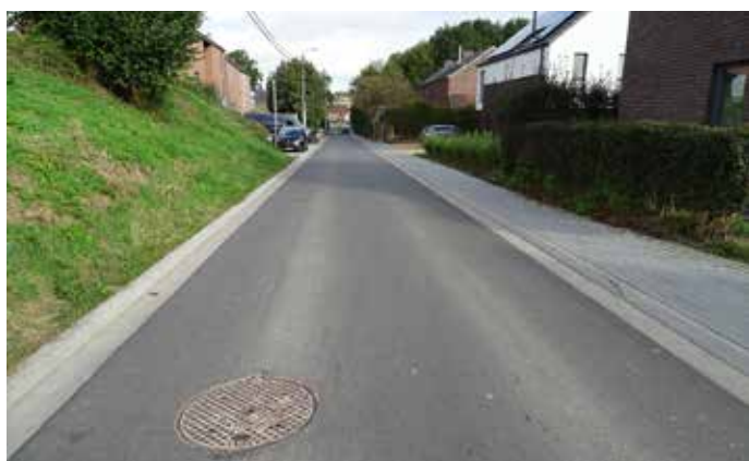
Rue Pichelin à Tongrinne : réfection de la route, des égouts et des trottoir
