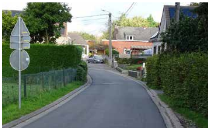
Rue de la Motte à Sombreffe : réfection d'une portion de route
