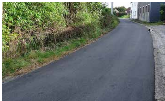
Rue des Fonds à Tongrinne : réfection d'une portion de route
