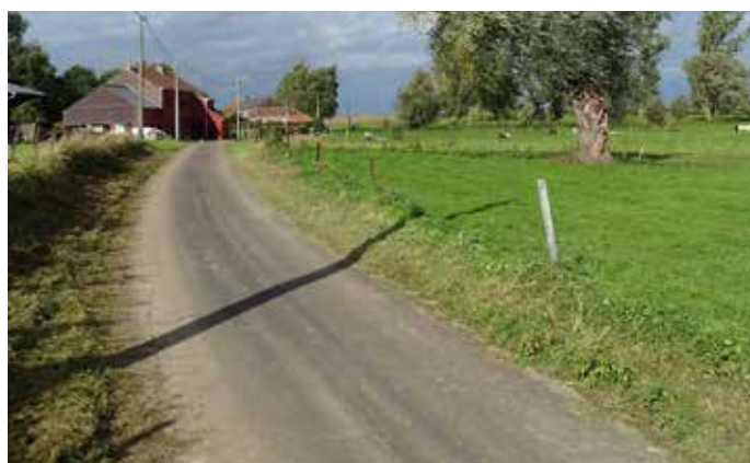
Rue Croix Brûlée à Sombreffe : enduisage de la route
