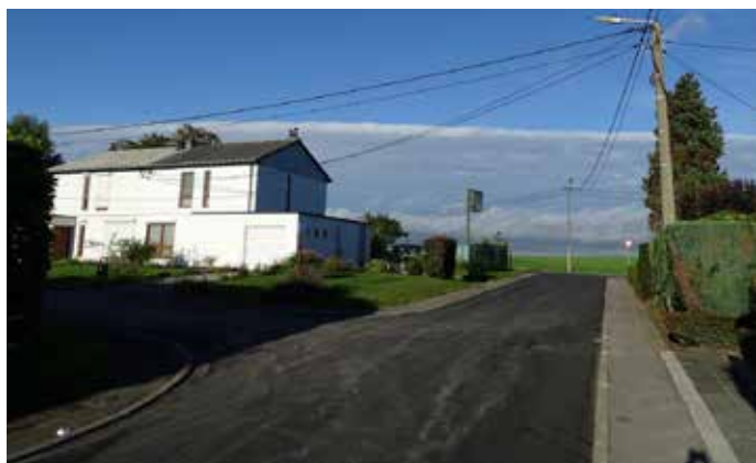
Rue Bassée à Sombreffe : réfection de la route
