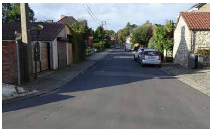
Rue René Gobert à Ligny : réfection d'une portion de route
