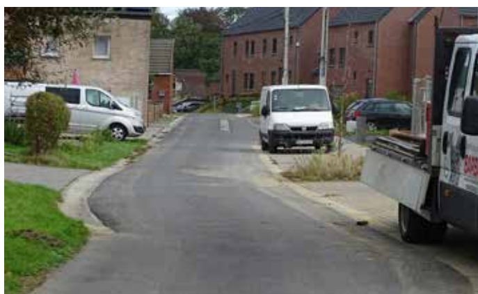
Rue des Hurchets à Sombreffe : réfection de toute la rue
