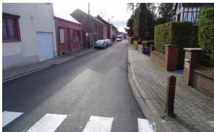
Rue Saint-Nicolas à Ligny : réfection de la route
