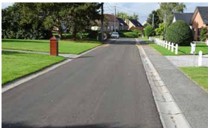
Rue Gironfontaine à Sombreffe : enduisage d'une portion de route
