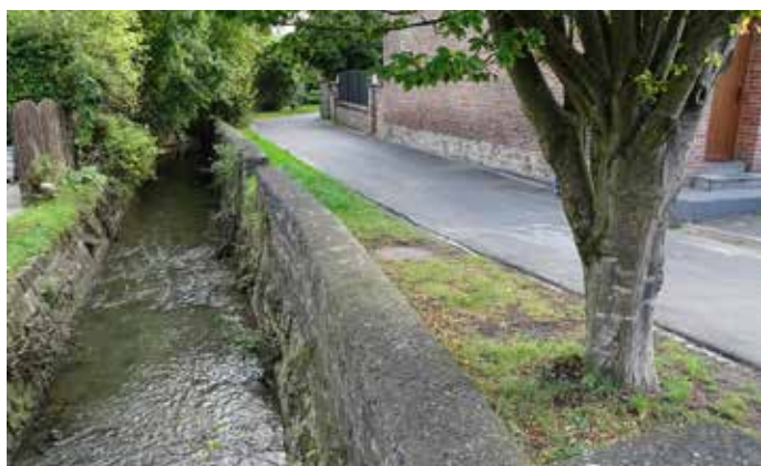
Rue du Grand-Cortil à Ligny : réfection de la route
