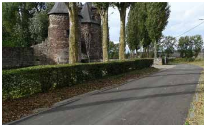
Rue du Château à Sombreffe : enduisage de la route
