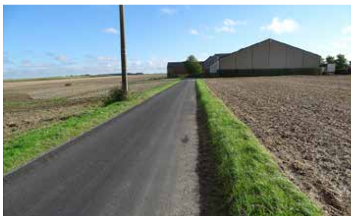
Chaussée Romaine à Sombreffe : réfection d'une portion de route
