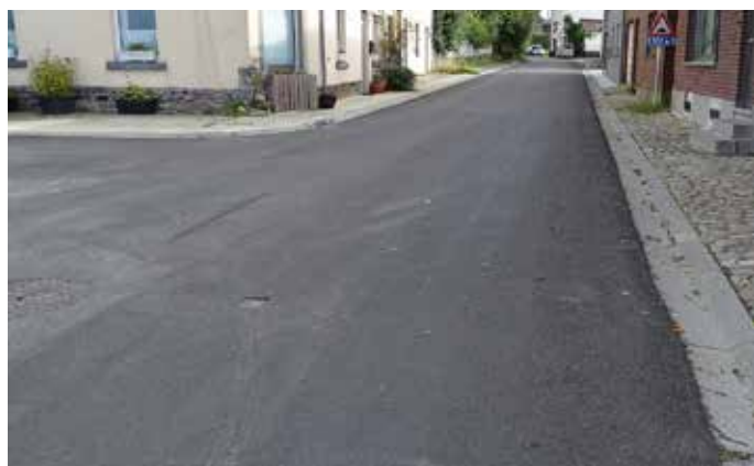
Rue Ottiamont à Sombreffe : enduisage d'une portion de route
