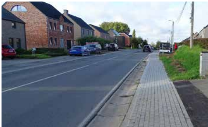
Les trottoirs ont été refaits rue Bois du Loup à Ligny
