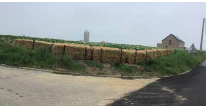
Système de rétention des boues provenant des champs agricoles au carrefour entre la rue Gironfontaine et la rue de Wavre à Sombreffe.
