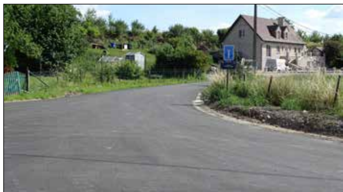
Réfection de la rue des Chapeliers à Tongrinne
