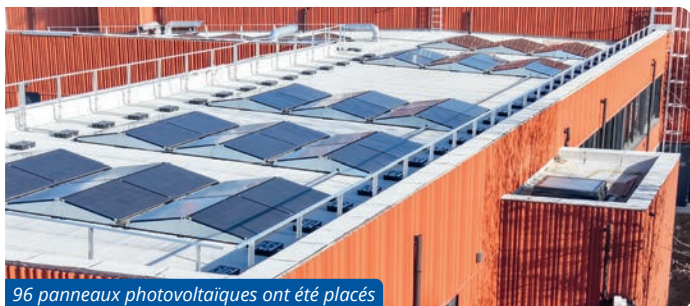
96 panneaux photovoltaïques ont été placés
